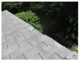
MINOR SHINGLE DAMAGE ABOVE RAKE #R
